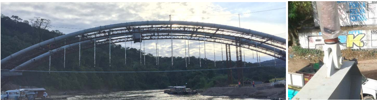
Figura 3. Alzado estructura durante instalación de péndolas y conexión viga-péndola
