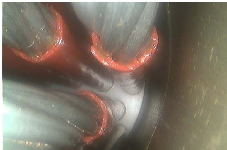
Figura 5: Interior de un anclaje vaciado
