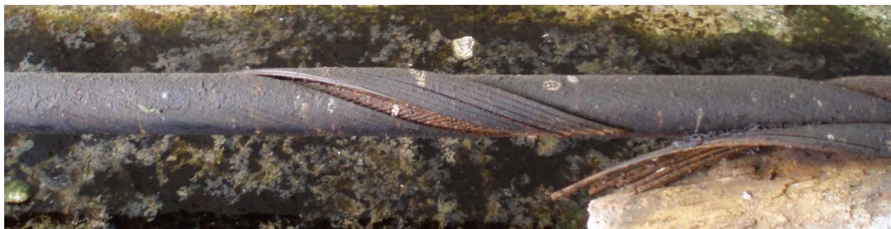
Figura 1: Hilos exteriores rotos en cable cerrado
