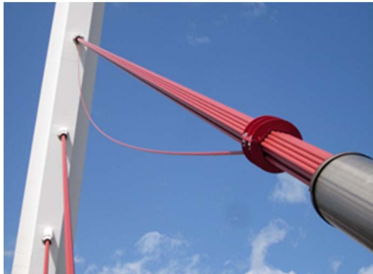
Figura 3: Rotura de un cordón
