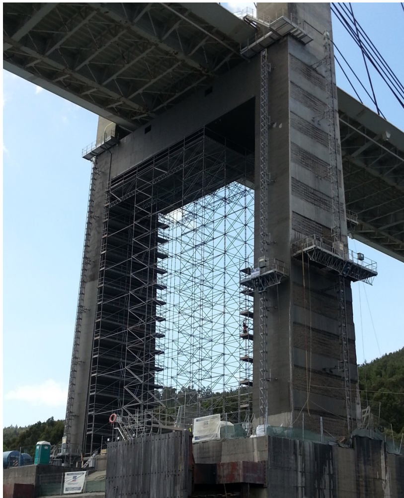
Figura 6. Andamio pila Norte.
