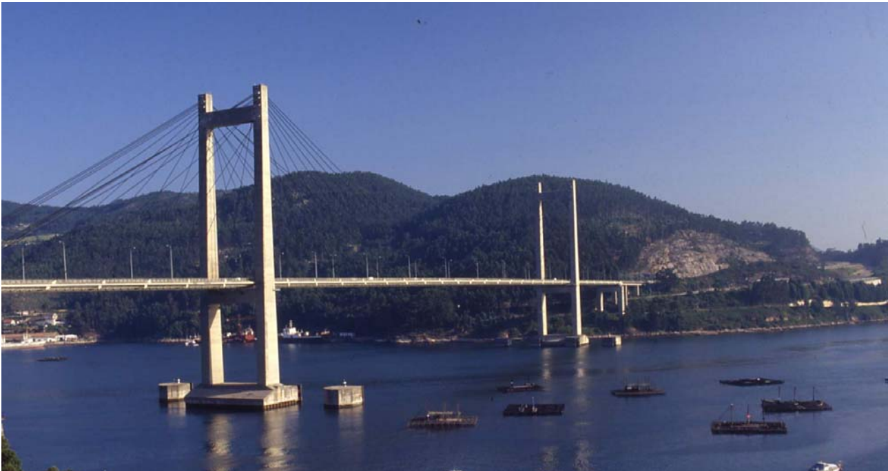
Figura 1. Vista general del puente de Rande.
