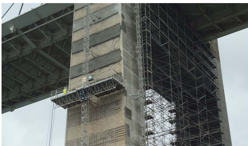
Figura 4. Reparación por bataches.
