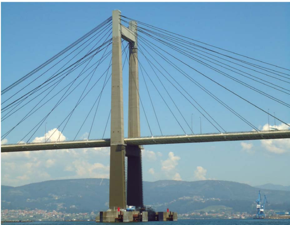
Figura 5. Aspecto final tras reparación.
